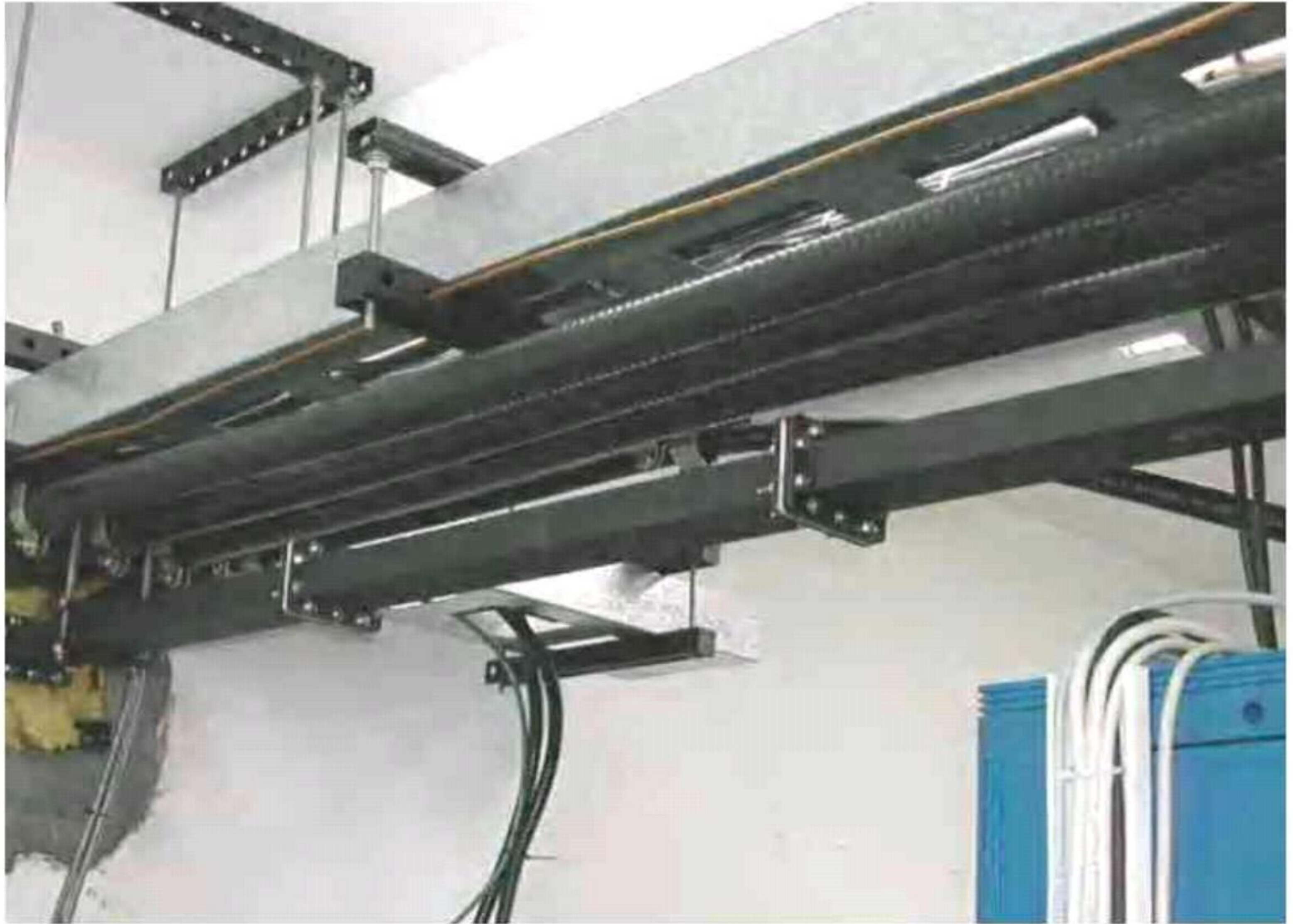
连接设备和天线的馈线
